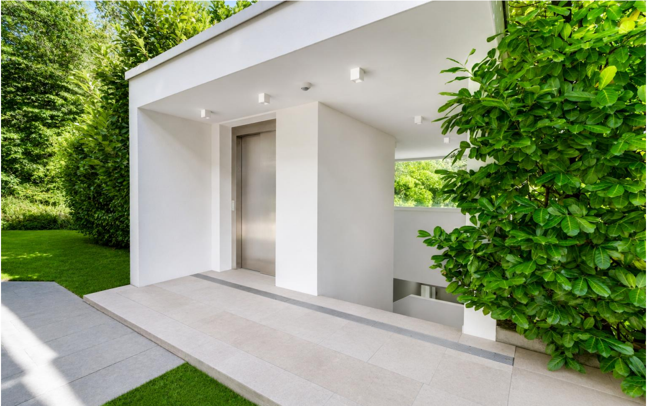
Aufzug Garagengeschoss zum Gartengeschoss
